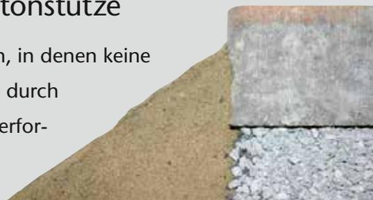
die Gestaltungsmöglichkeit des Auslaufenlassens von Flächen an. Eine Befestigung dieser Flächen erzielt man durch eine Frischbetonstütze an den Pflastersteinen. Diese sollte ca. 2 cm unterhalb der Oberkante des Pflasters ansetzen und bis auf das Schotterbett gehen. Direkt auf diese Frischbetonstütze kann Erdreich, Rasen oder Mulch gegeben werden. Somit wird ein „unsichtbarer Halt“ der Fläche erreicht.
