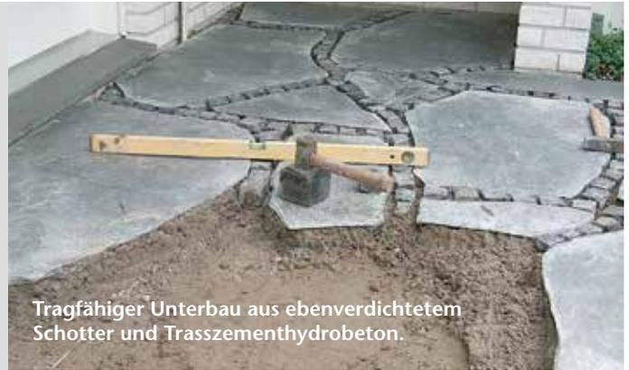
ist ebenso unabdingbar, wie der wasserdurchlässige Mörtel aus Trasszementhydrobeton, in den die Platten verlegt werden. (Trasszement sollte aufgrund der geringen Neigung zu Ausblühungen verwendet werden). Oberflächenwasser kann somit ans Erdreich abgegeben werden und Frostschäden am Unterbau können damit vermieden werden.
